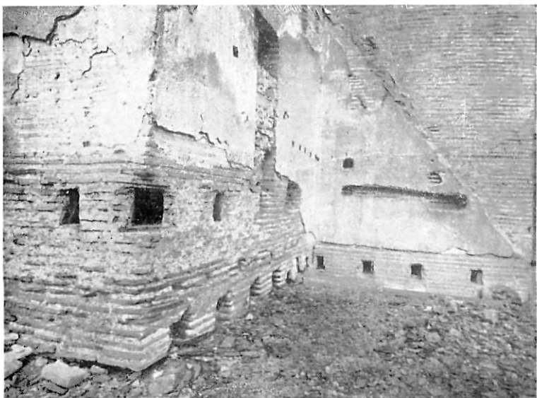
8. Tréveris .—Basílica: Torre oriental. Agujeros de los balcones de la galería superior.
