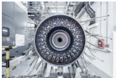
Eine Industriegasturbine des Typs LM2500, die bei den Stadtwerken Augsburg zur Energieversorgung beiträgt und die dank des engagierten Einsatzes eines Field Service Teams aus Ludwigsfelde wieder läuft.
