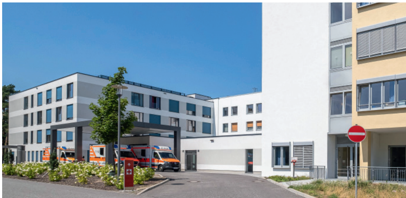
Das Evangelische Krankenhaus Ludwigsfelde wurde 2020 um einen Neubau für die Rettungsstelle und das Bettenhaus Chirurgie erweitert.
